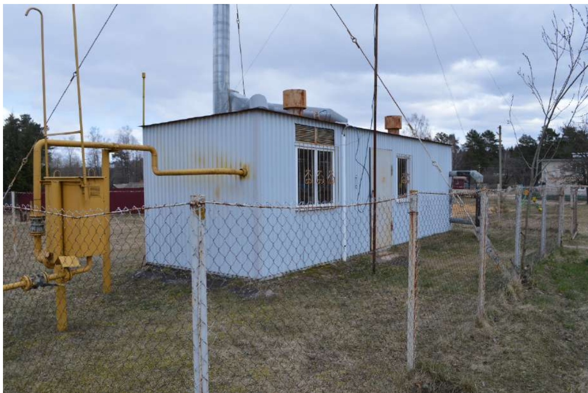
Фото Ф1. Общий вид котельной (снаружи).
